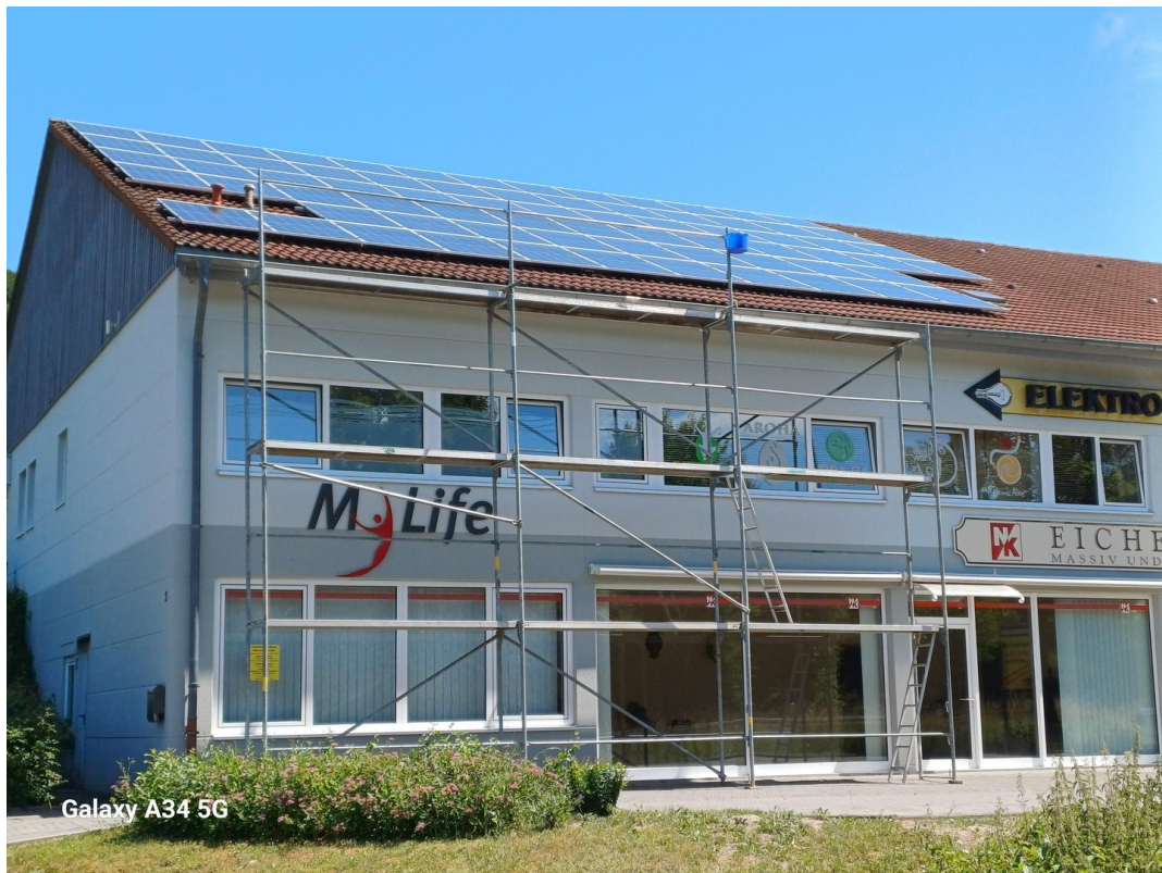
Neuinstallierte PV-Anlage 30KW
