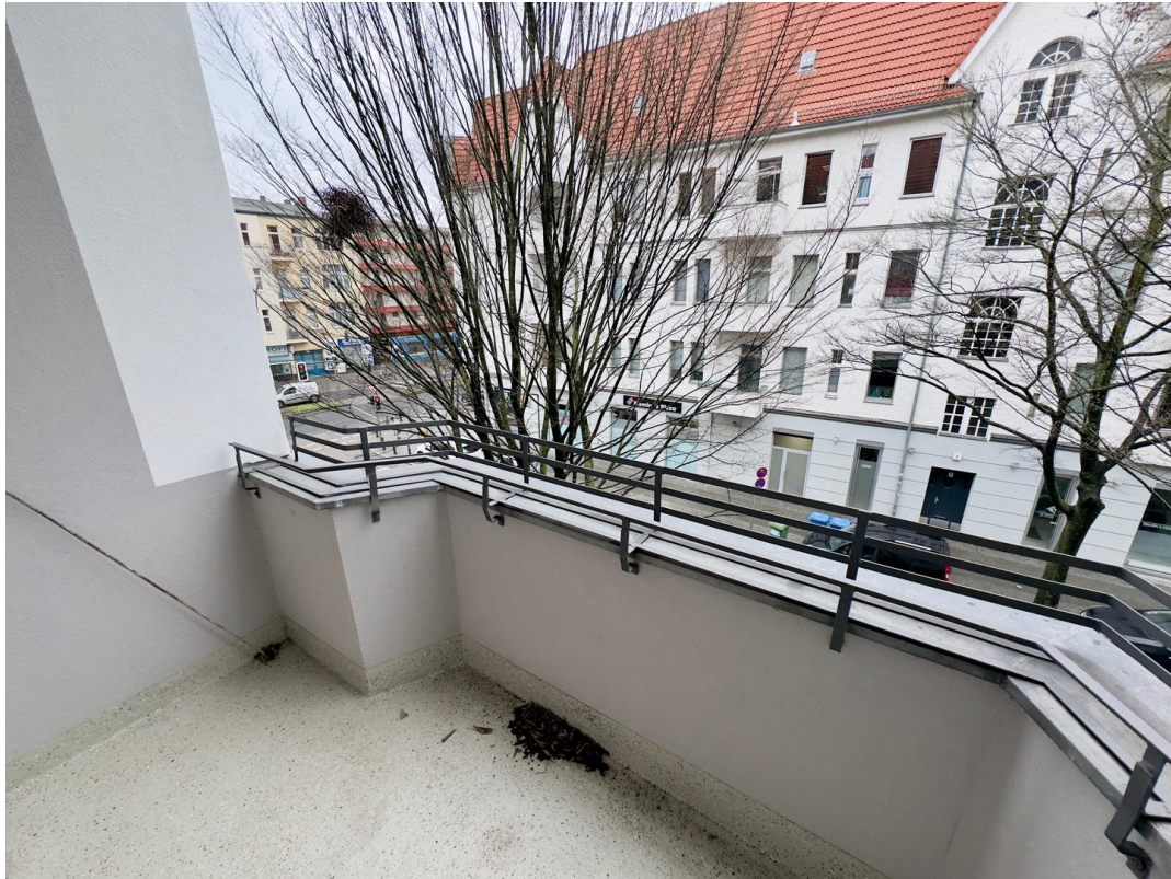
Westbalkon neu renoviert
