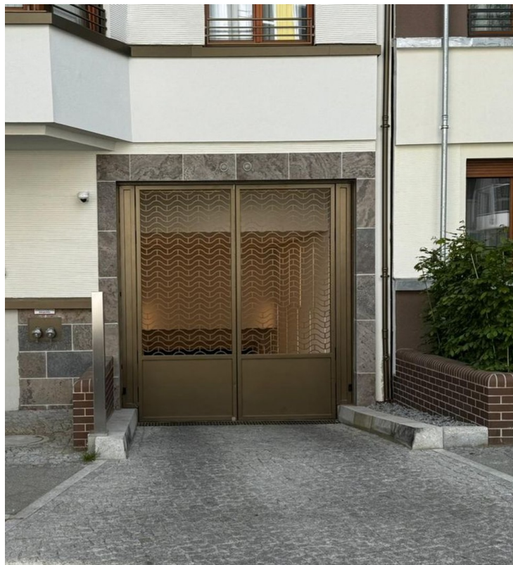
Tor zur Tiefgarage
