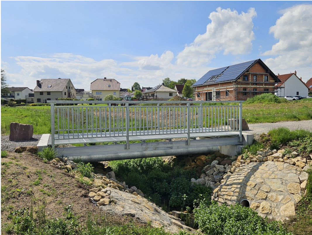
Brücke Sudheimer Graben
