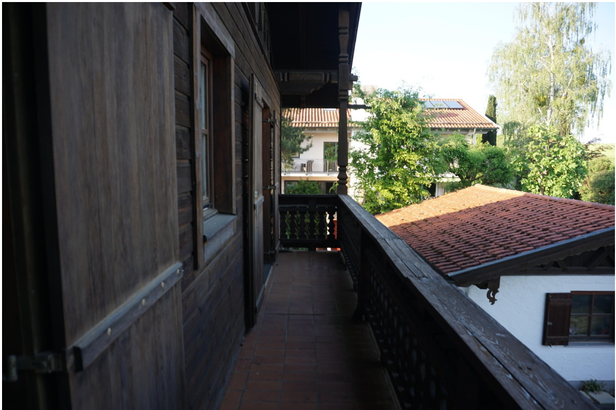
Balkon Ostseite 1. OG
