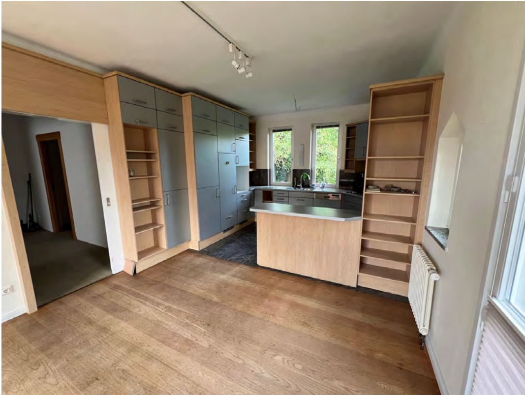
Fußboden Eiche Massivdielen
