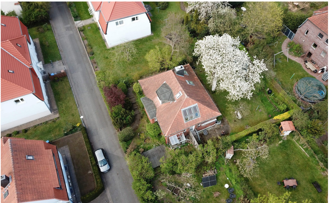
Luftbild-Ansicht von Südwesten
