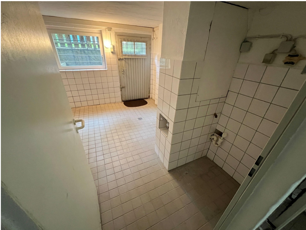
Waschküche mit Außentür
