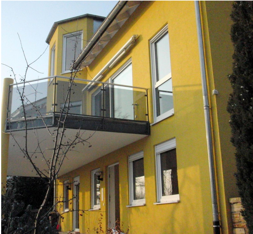
Hausfront Terrasse und Balkon
