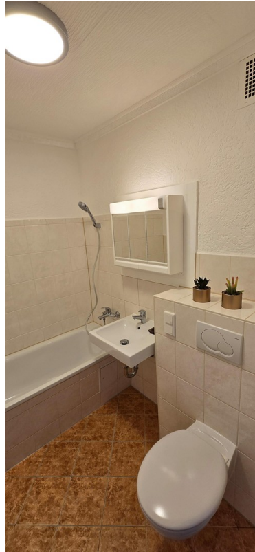
Bad mit altem Bodenbelag
