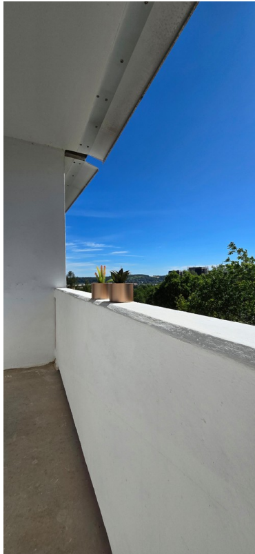
Balkon noch ohne Bodenbelag
