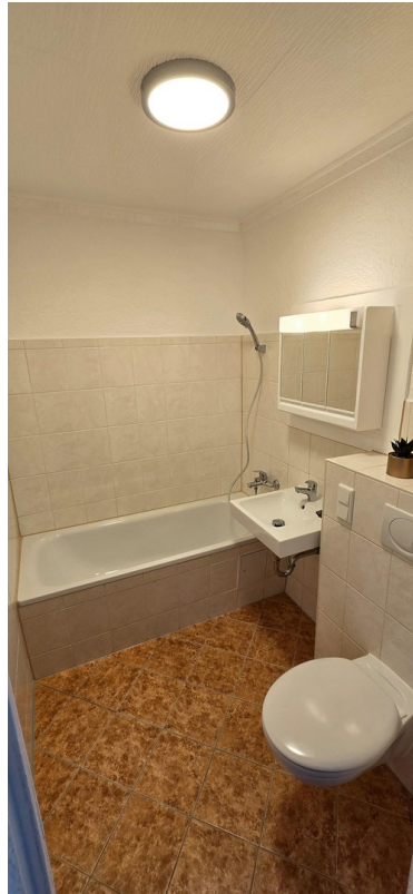
Bad mit altem Bodenbelag
