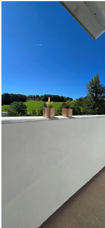
Balkon noch ohne Bodenbelag
