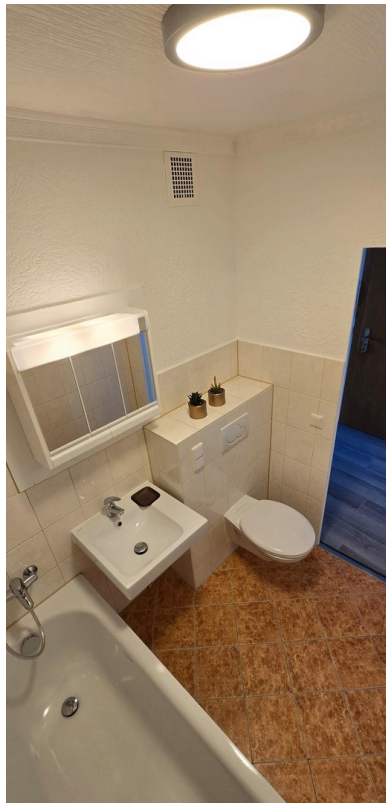
Bad mit altem Bodenbelag
