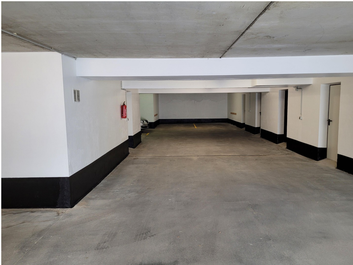
Tiefgarage mit Mieterkellern
