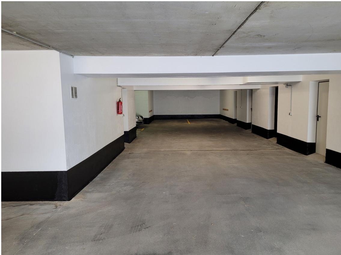
Tiefgarage mit Mieterkellern
