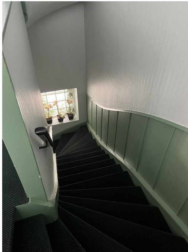
Treppenhaus EG - 3.Obergeschoß
