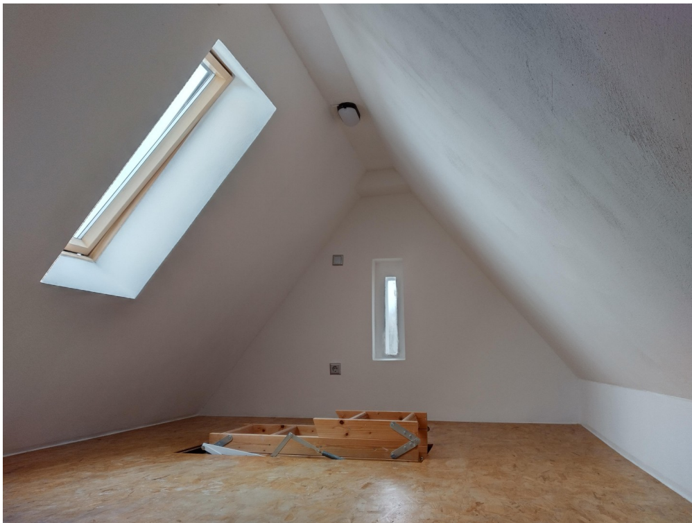
Spitzboden im DG EFH
