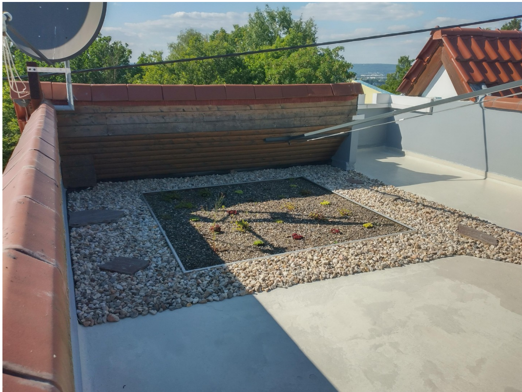
Dachterasse auf dem Anbau EFH
