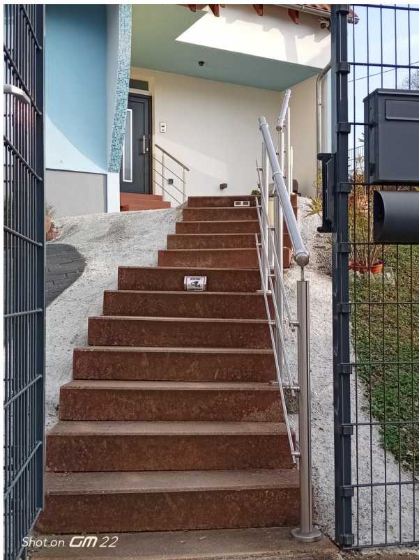
Treppe zu den Eingängen
