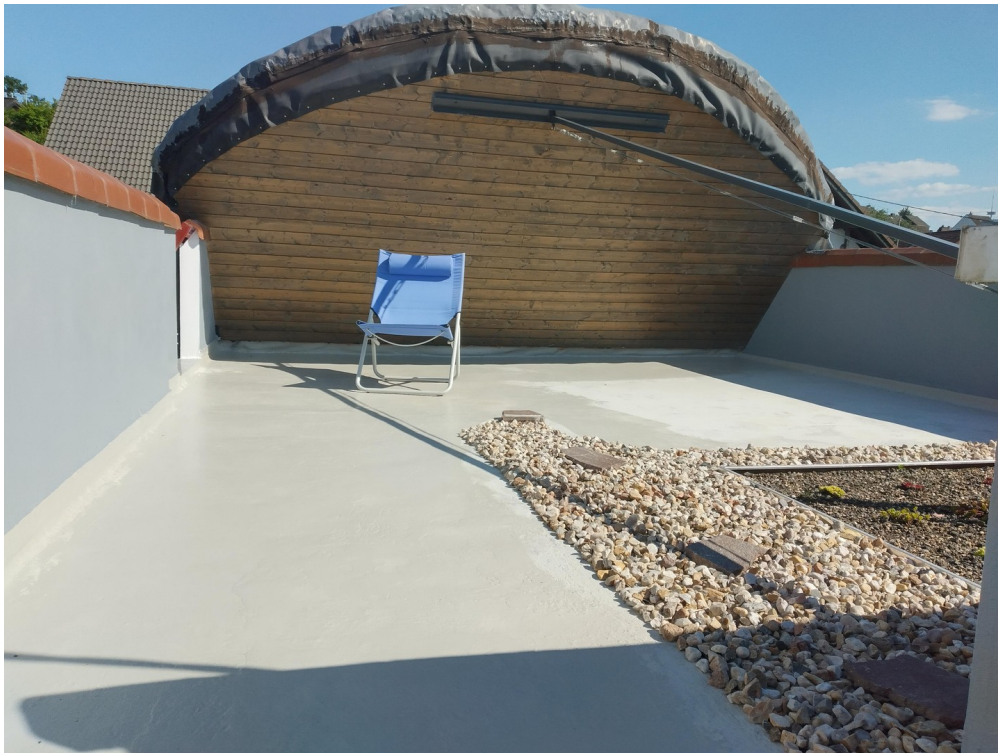
Dachterasse auf dem Anbau EFH
