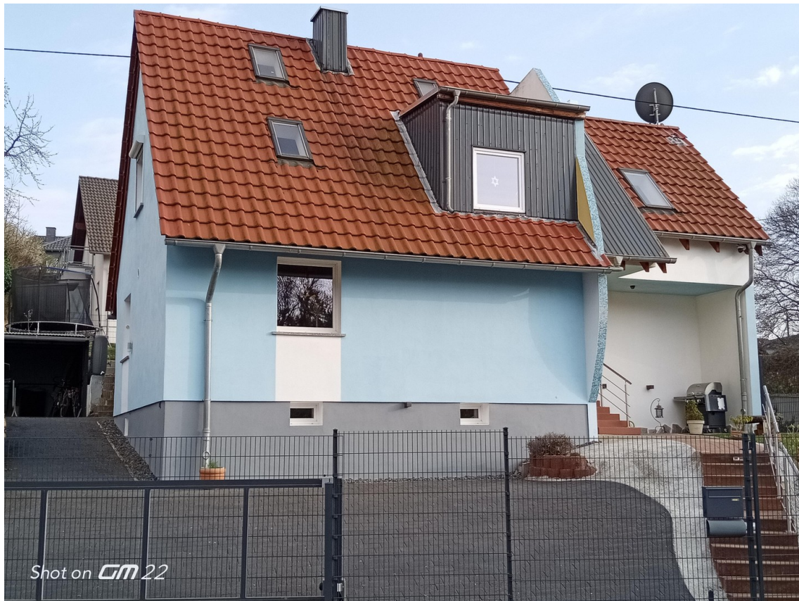
Straßenansicht von links
