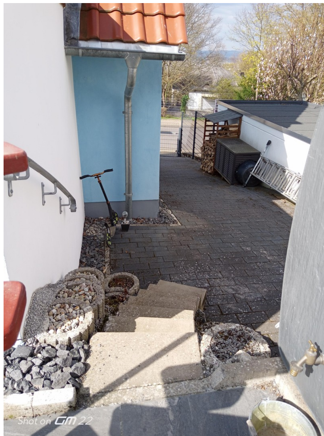
Außenzugang zu Terrasse EFG
