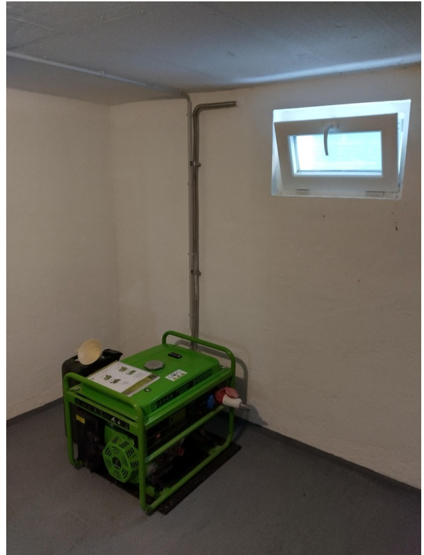
5 KW Strom-Aggregat im Keller
