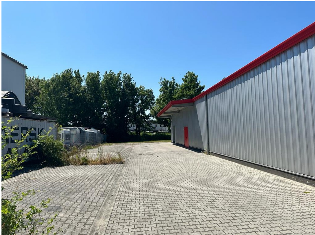
Befahrung Südseite Anlieferung
