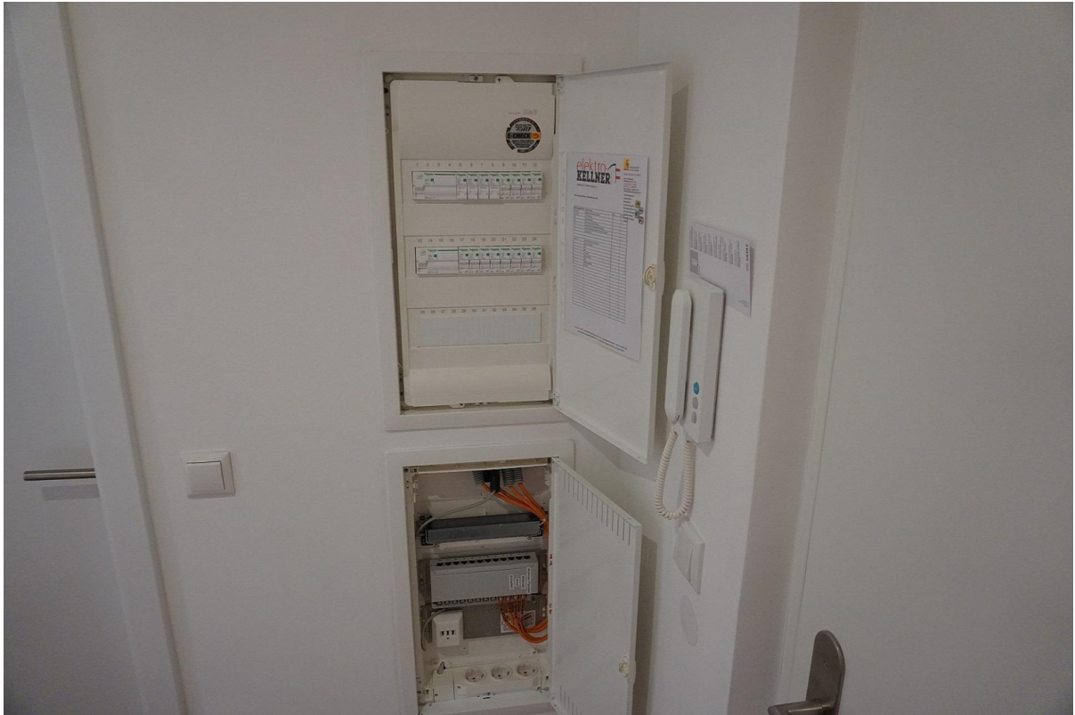
neue Installation ELT u. LAN
