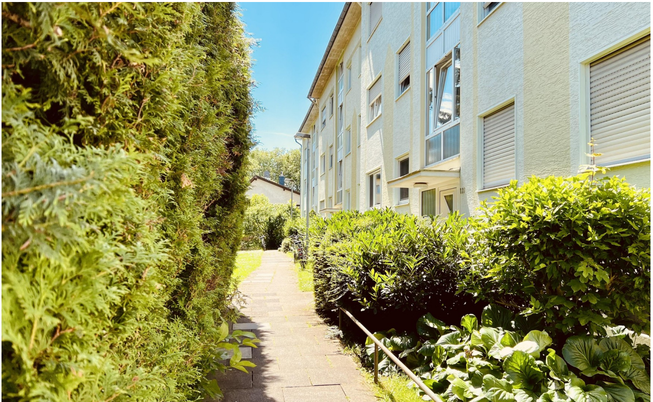
Gang zum Eingang des Hauses
