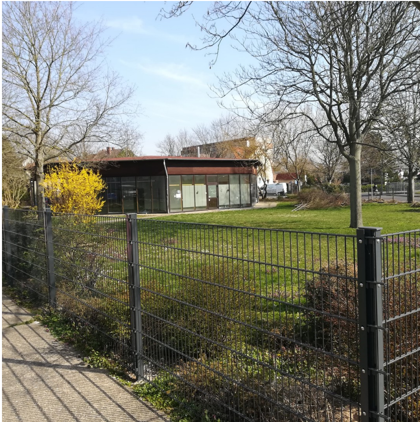
Blick von Südwest
