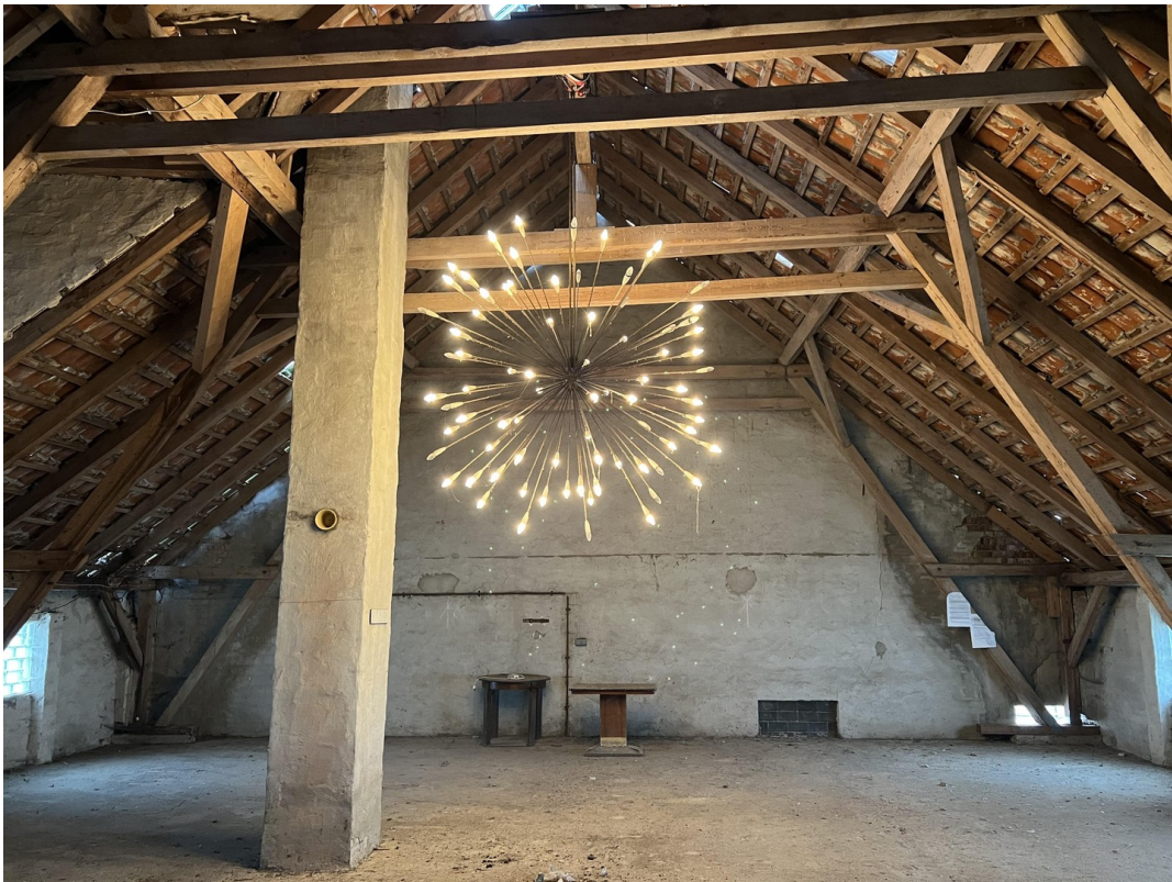
OG im Stallgebäude
