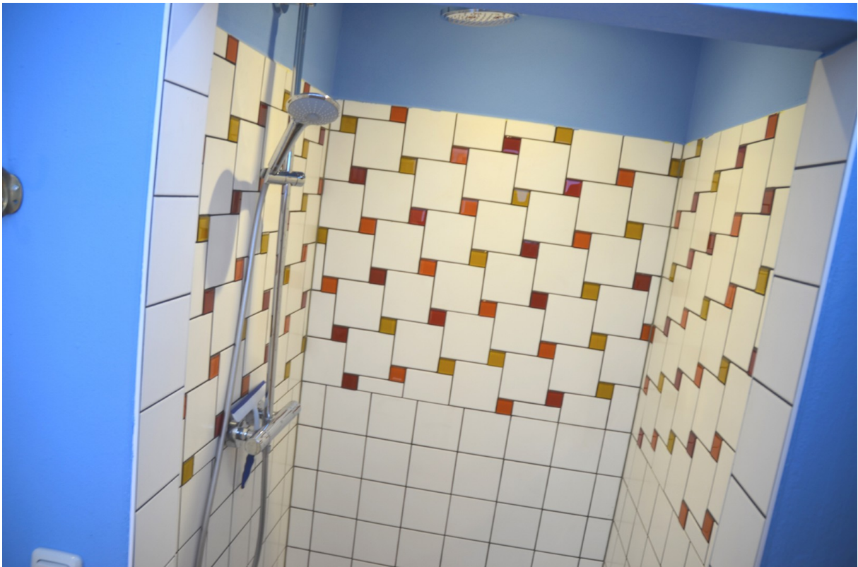
Umkleiden mit 4 Duschen
