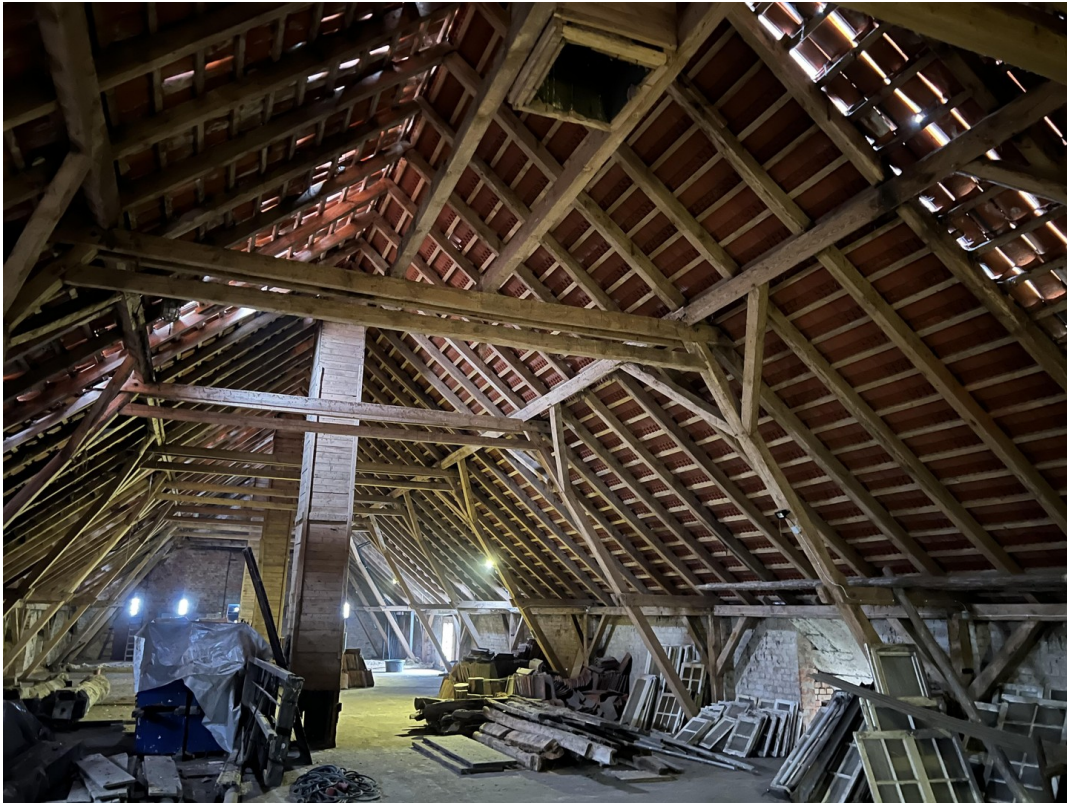
Ausbau-Dachgeschoss im Stall
