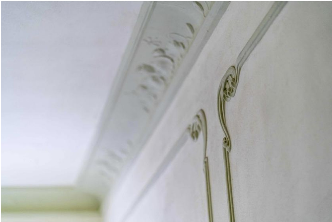
Stuck im Treppenhaus
