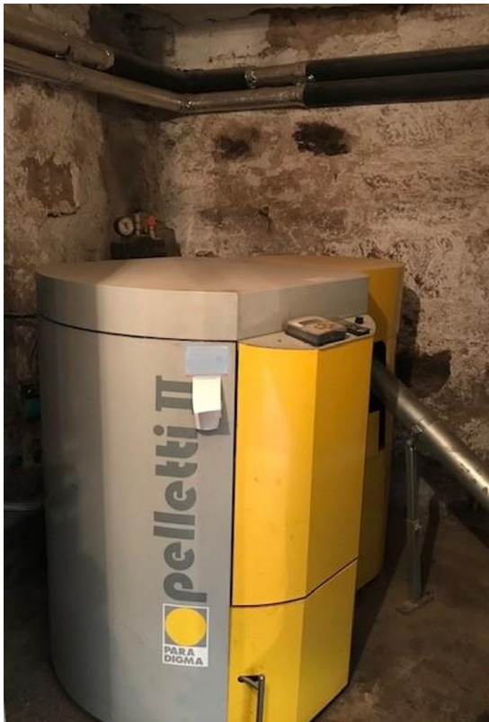
Technikkeller Pelletzentralh.
