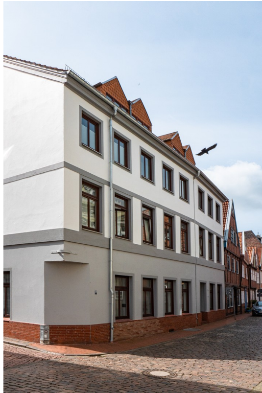
Eckausbildung des Gebäudes
