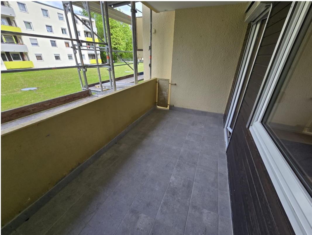
Balkon zum Innenhof
