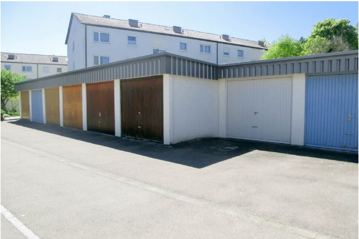
Einzelgarage und Stellplatz
