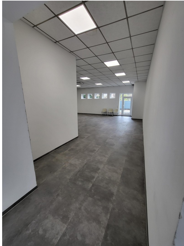
Zugang hinterer Teil
