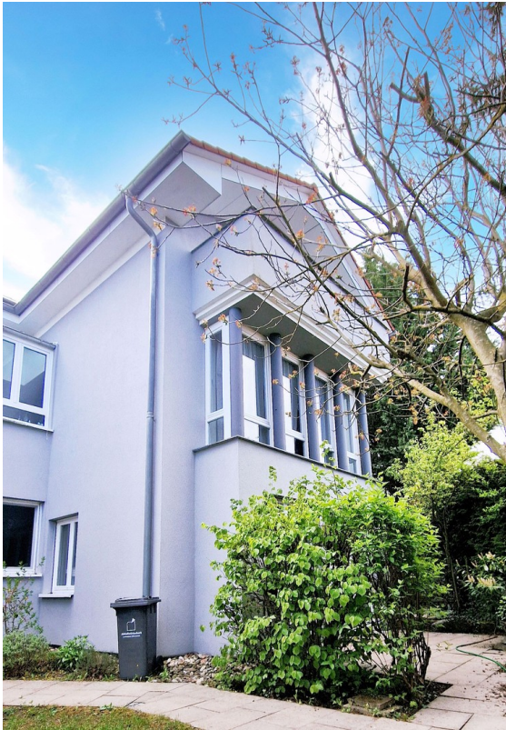
ELW (EG 1) Zugang
