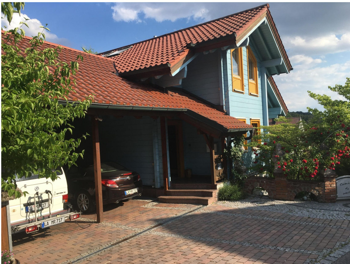
Westseite, Eingang und Carport
