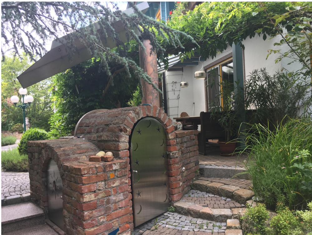
Pumpenhaus und Terrasse
