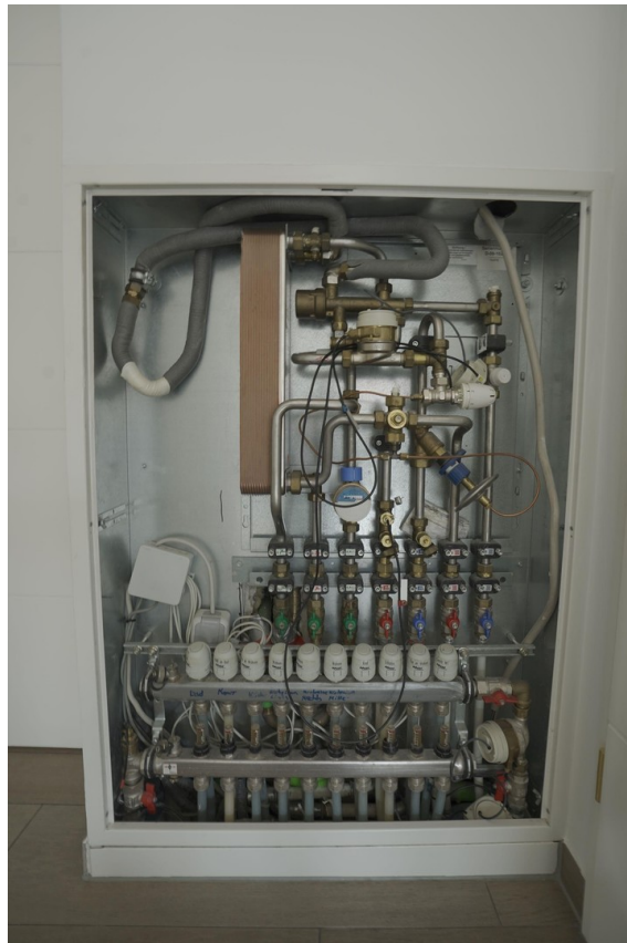
Frischwasserstation
