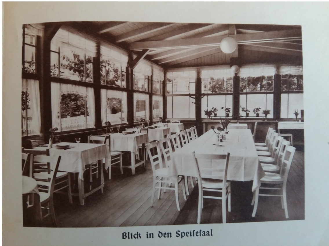
Alte Ansicht Speisesaal
