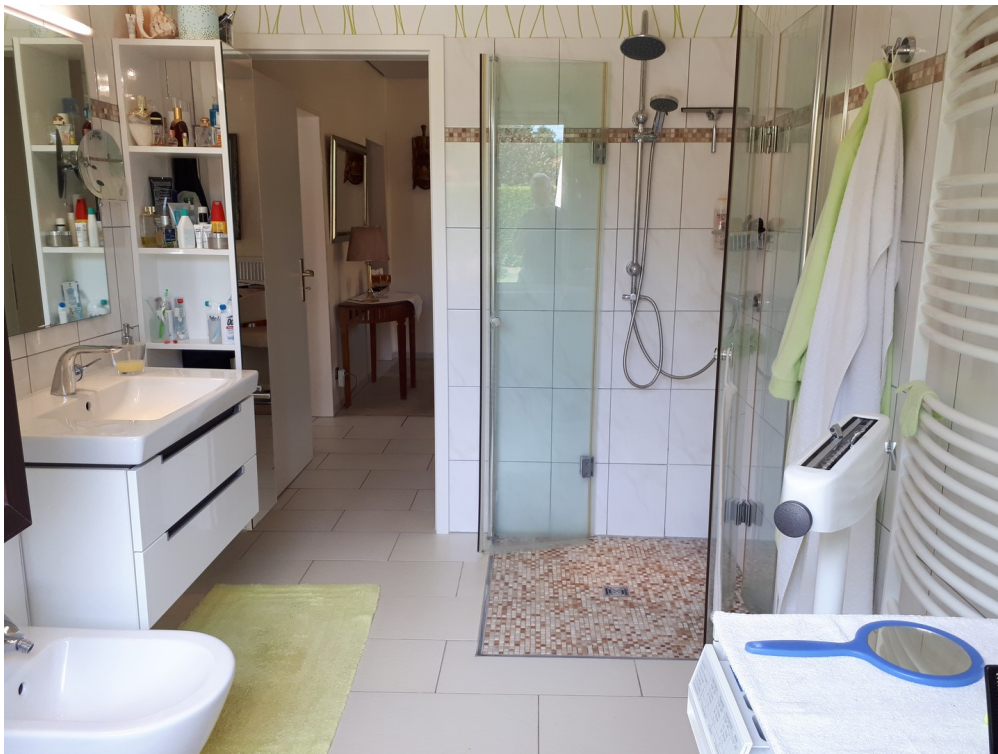
Bad - bodengleiche Dusche
