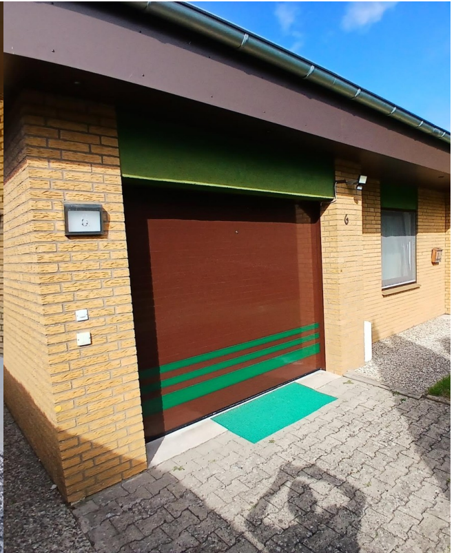
Bungalow - Süd, Garage
