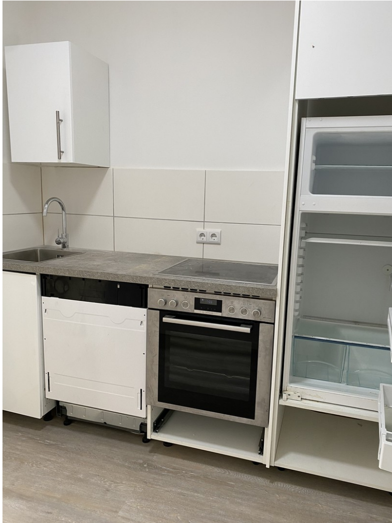
Küche (gerade im Einbau)
