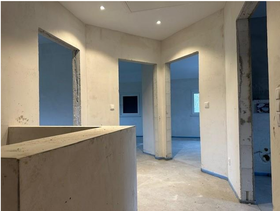
Flur OG + gemauerter Brüstung
