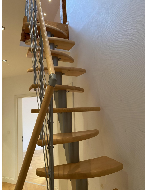
Treppe ins DG
