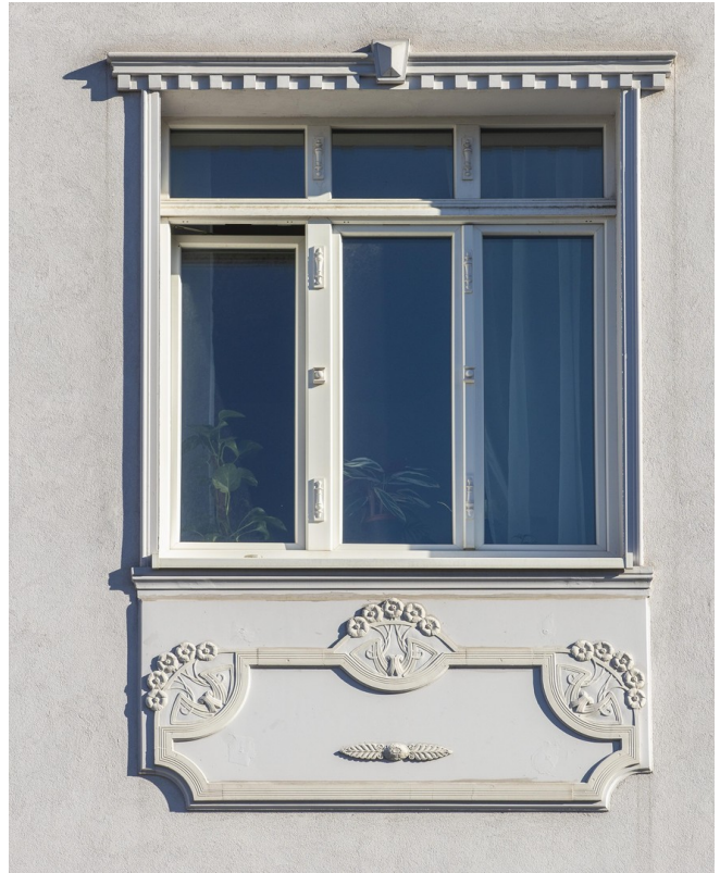
Wärmedämm-Fassade mit Stuck
