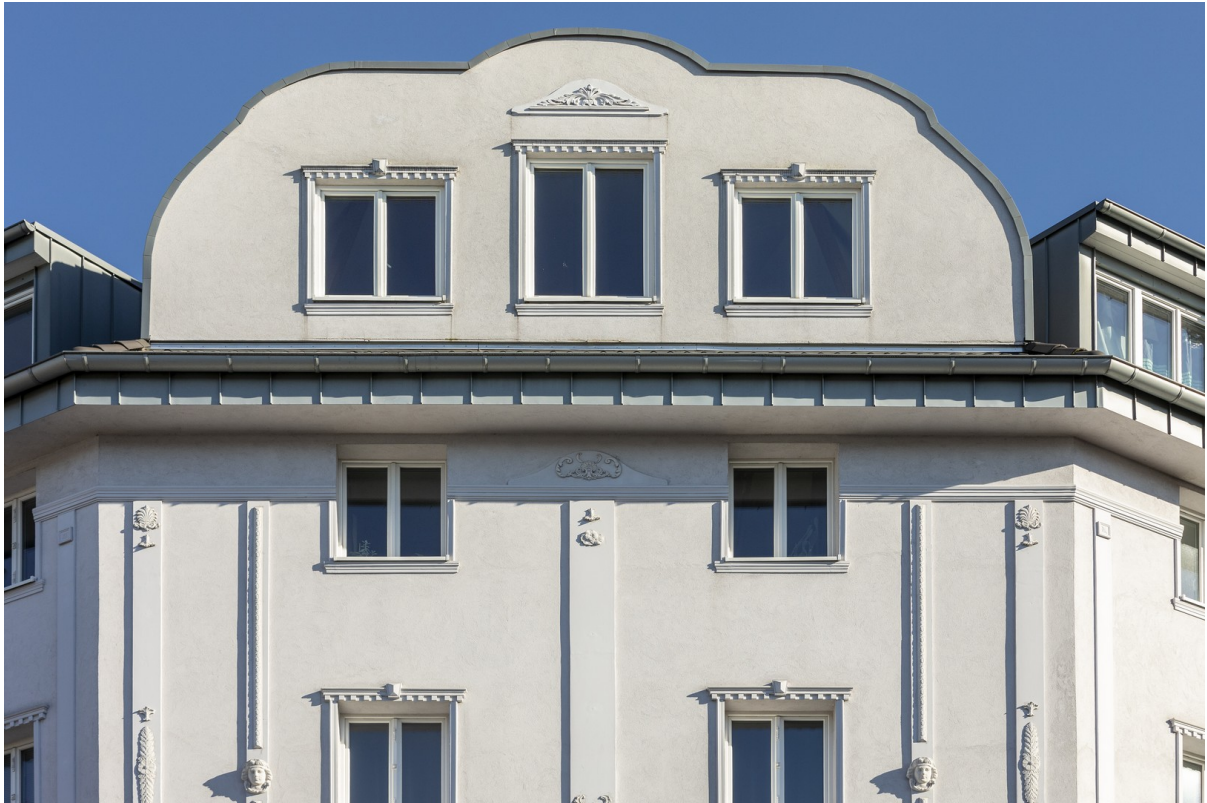
Wärmedämm-Fassade mit Stuck
