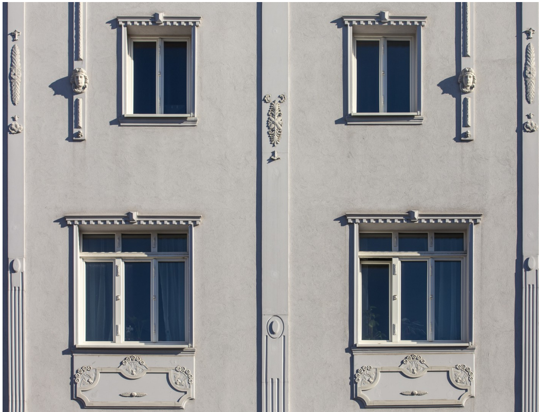
Wärmedämm-Fassade mit Stuck
