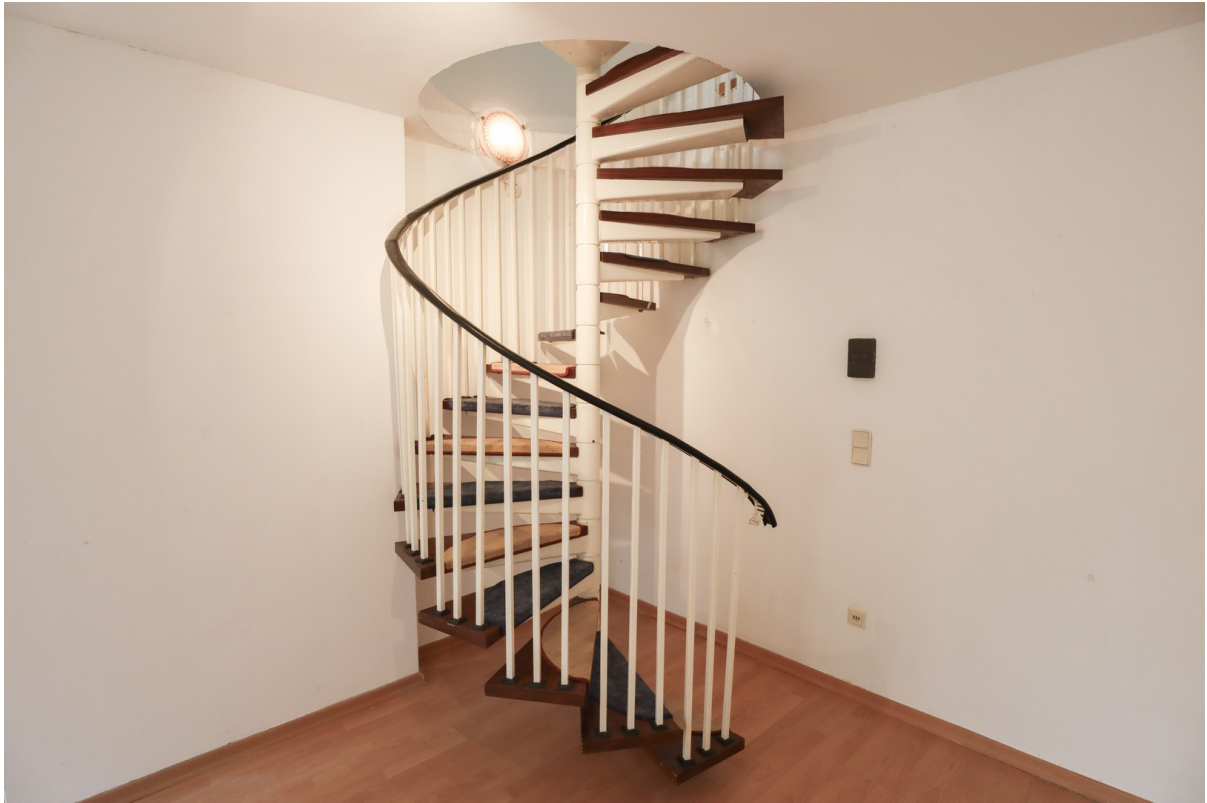
Wendeltreppe Schlafzimmer UG
