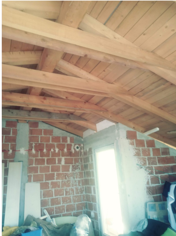
Dachgeschoß im Rohbau
