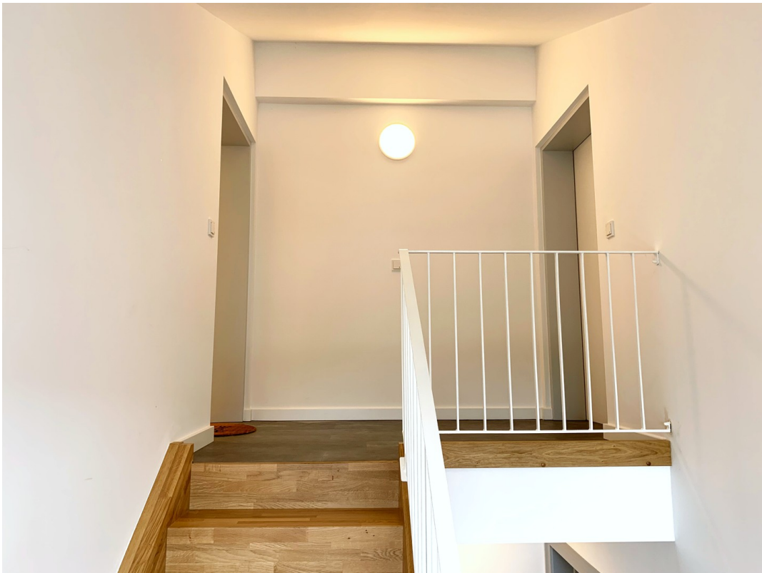
Treppenhaus vom Dachgeschoss
