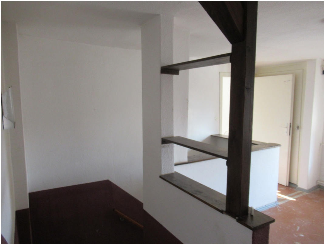
Flur Hinterhaus DG
