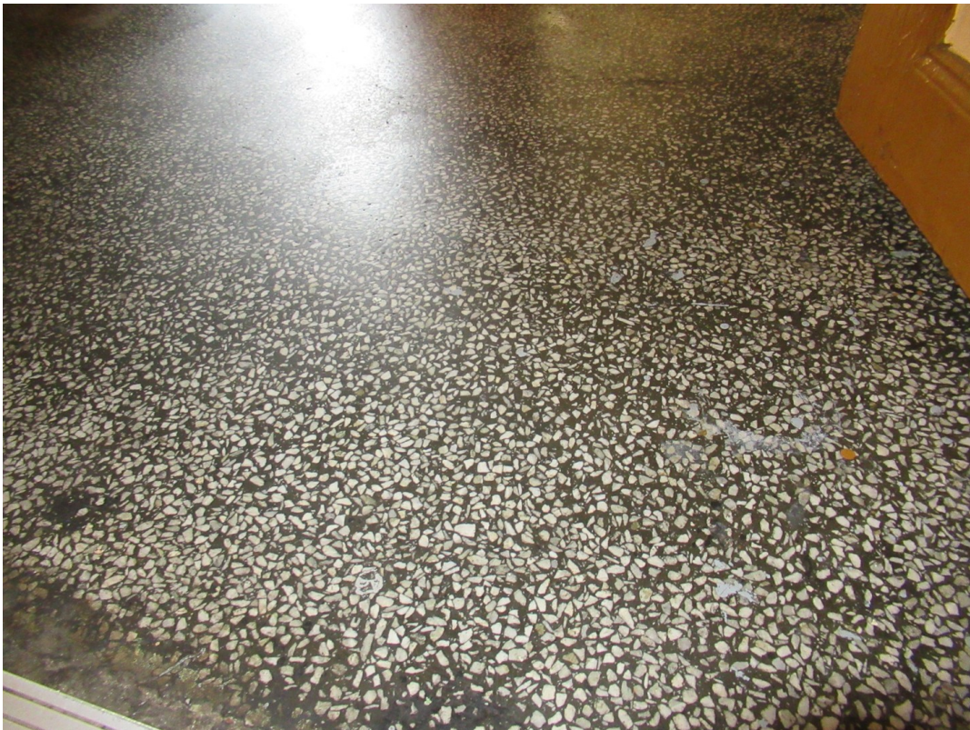
Detail Boden Vorderhaus
