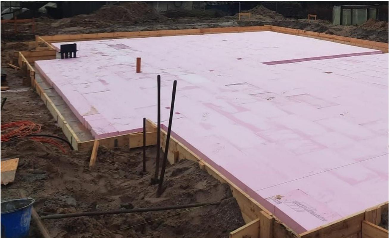
Dämmung unter Sohle
