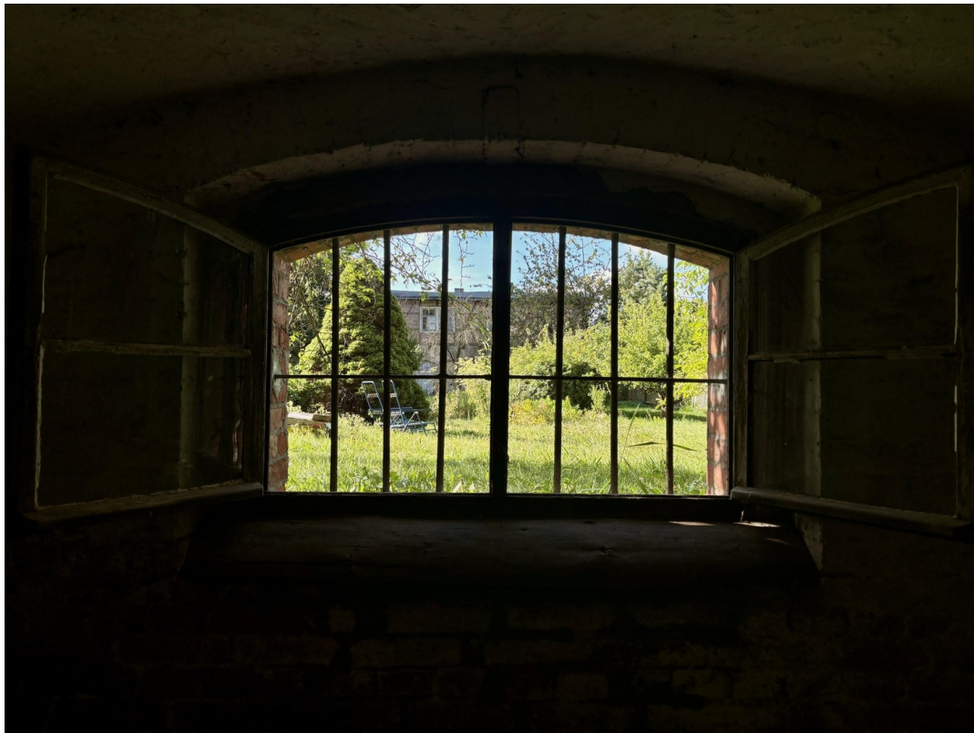
Souterrain Süden Garten
