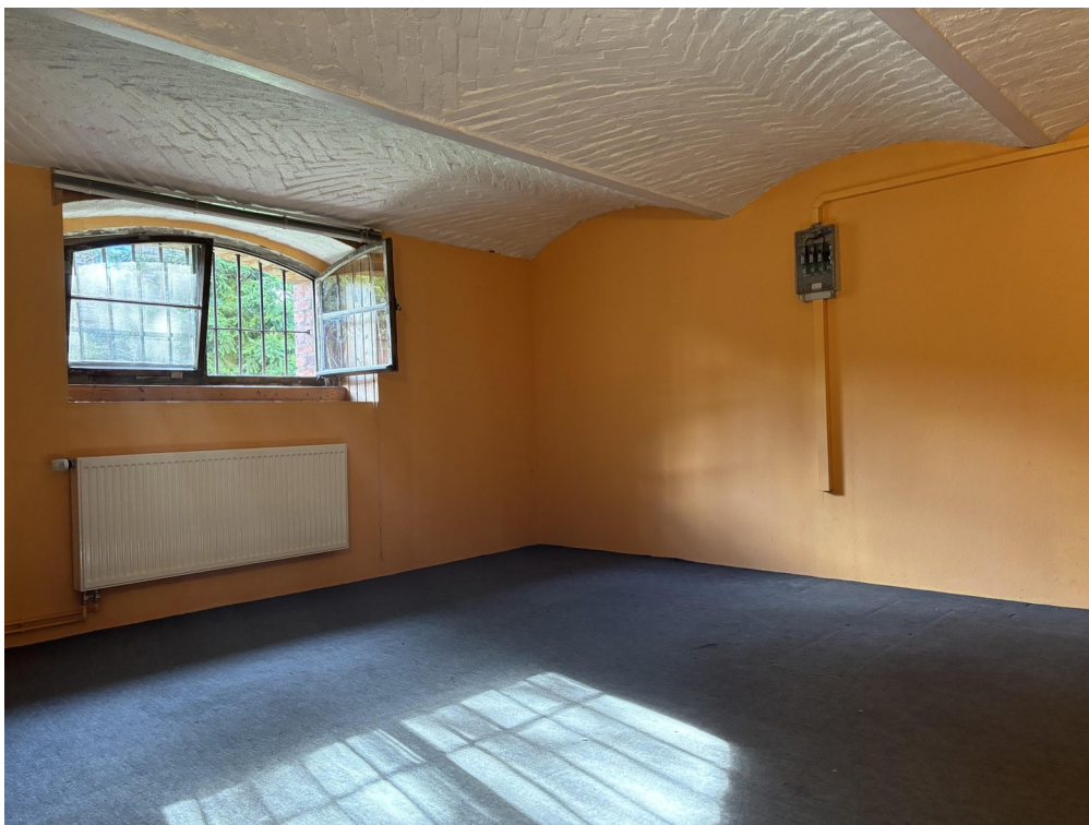
Souterrain Zimmer Osten
