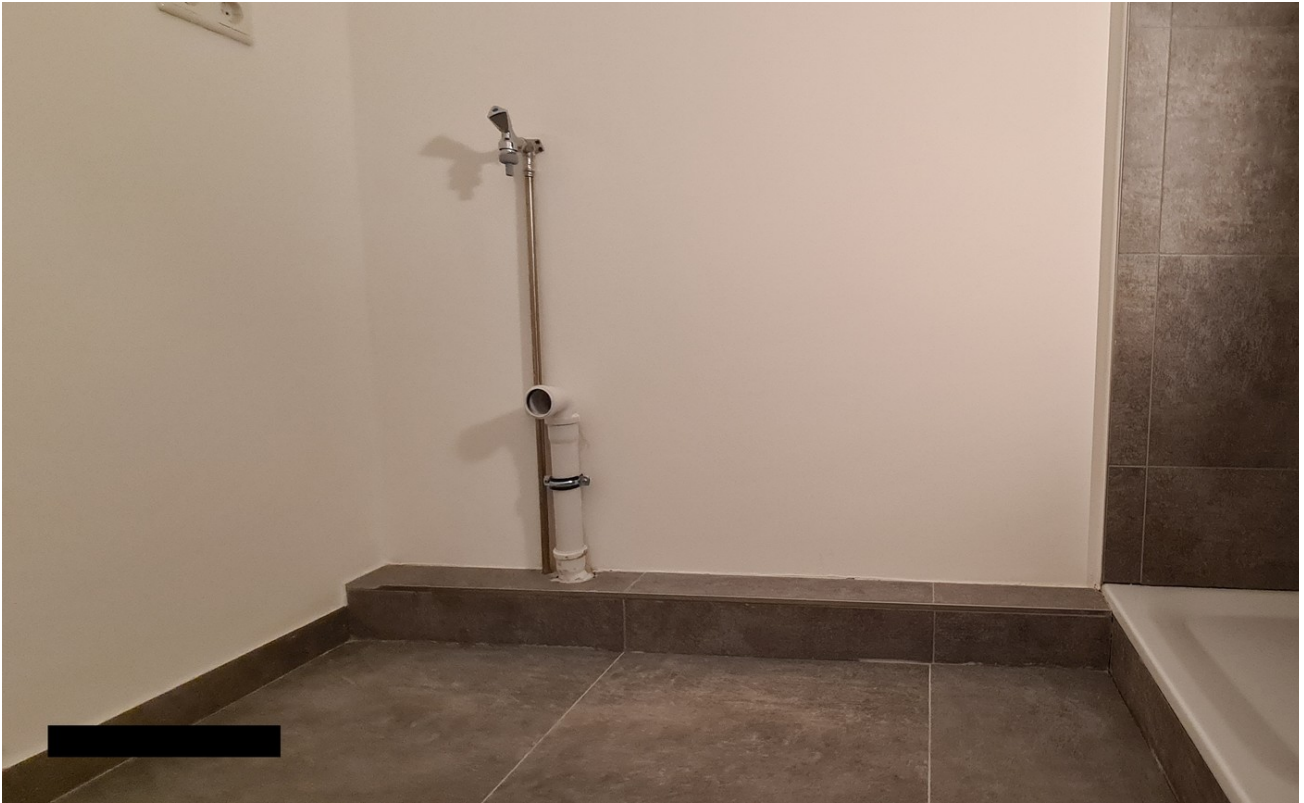
Waschmaschinenanschluss
