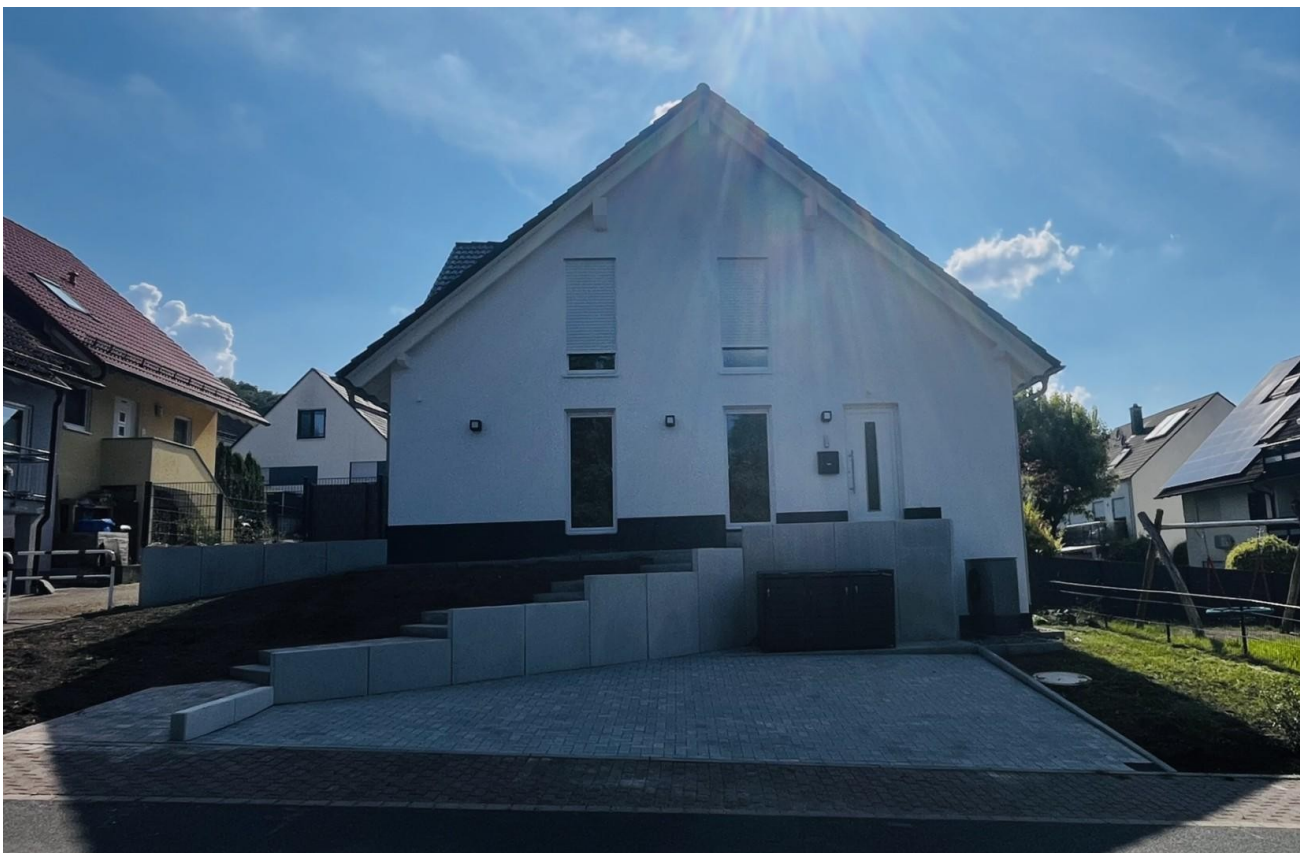
Außenansicht mit Stellplätze
