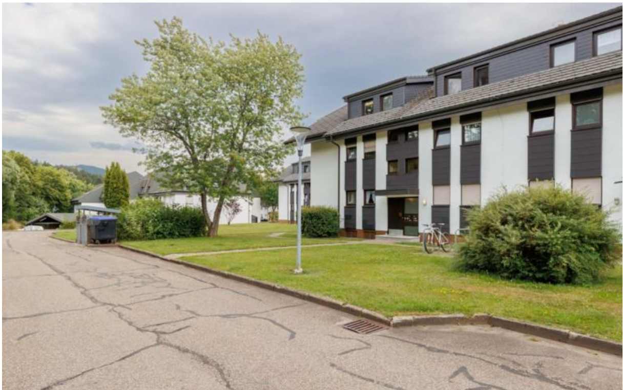
Hausansicht Zugang zum Haus
