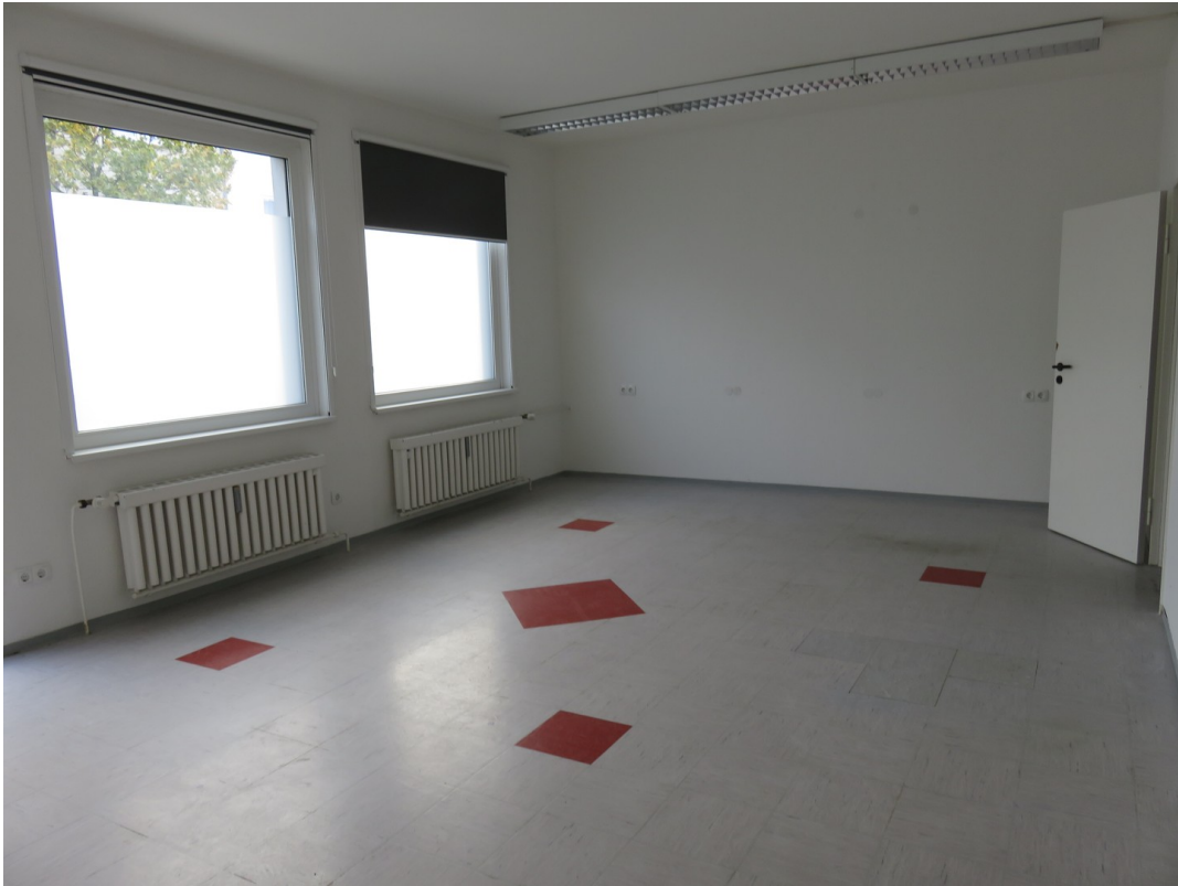
Ladenraum unter re.
