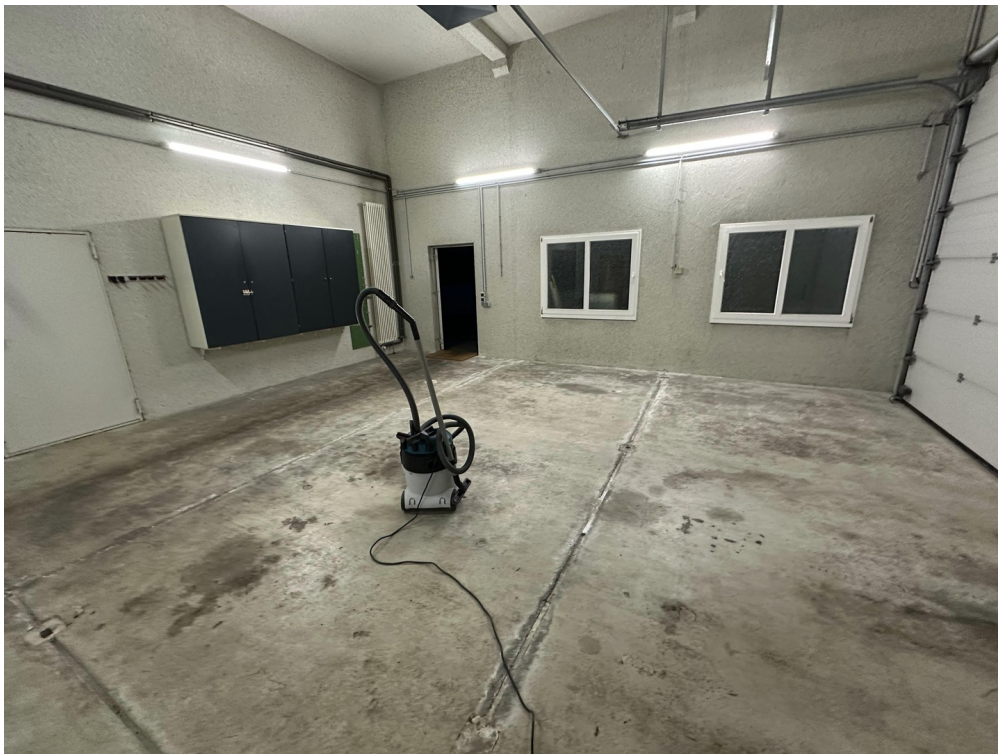
Heizgebläse und Radiatoren
