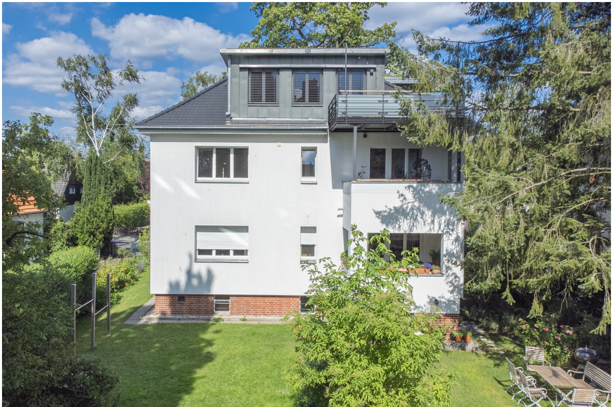
Dach und Terrasse neu
