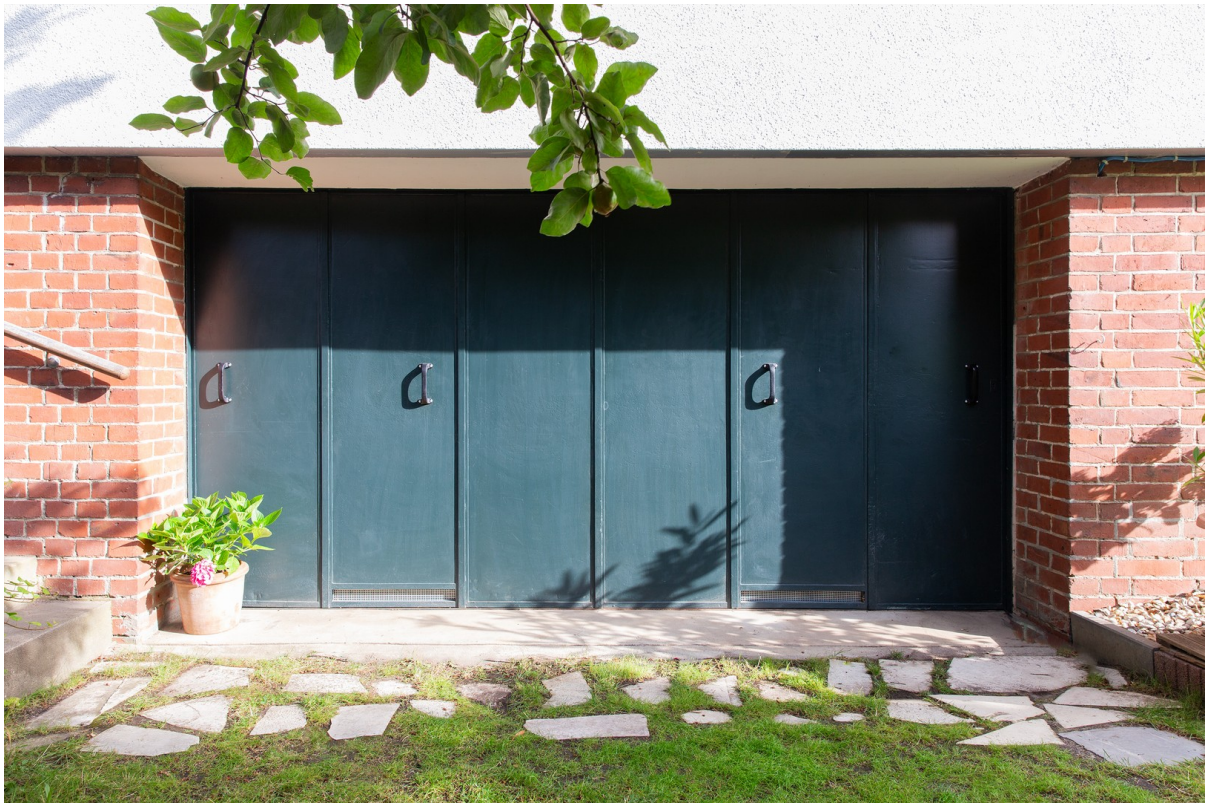
Restaurierte Garage (Lager)
