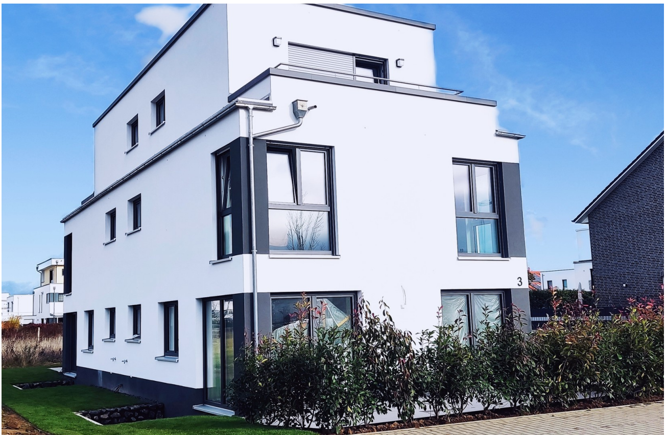
Der Blick von der Straße
