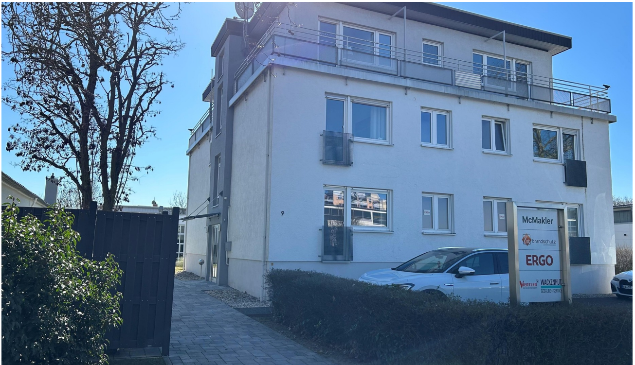
Außenansicht von Siemensstr.
