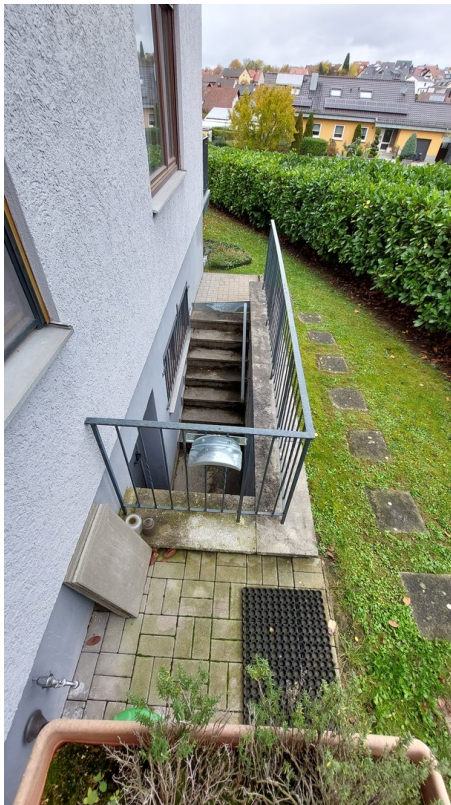
Außenzugang zum Lagerraum UG
