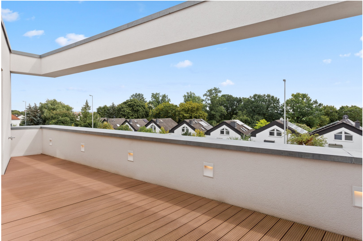
Dachterrasse im DG
