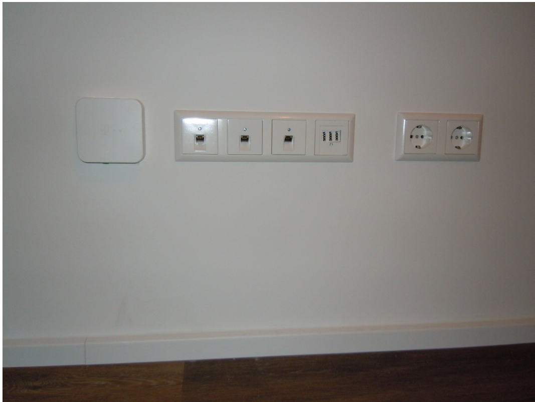
Glasfaseranschluß
