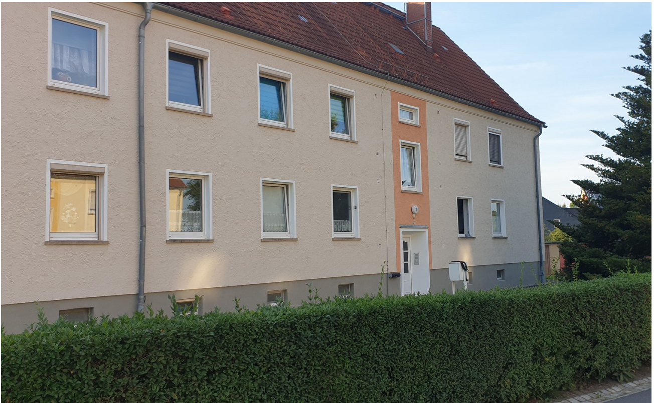
Haus Vorderansicht / Eingang
