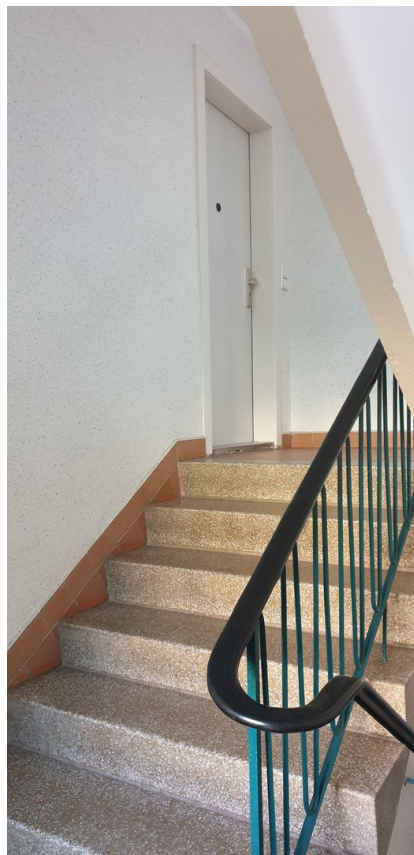
Treppe zur Wohnung im EG
